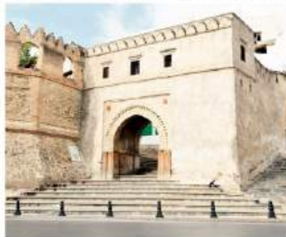
In die Medina gelangt man nur durch eines der sieben Tore, hier das Bab Oukh.
